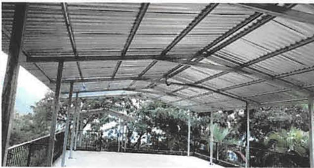
Foto 1: Estructura de metal e instalación de techo para evitar que se siga deteriorando la terraza, ya que en época de lluvias se filtra el agua a las aulas del primer nivel y las paredes se mantienen húmedas.
