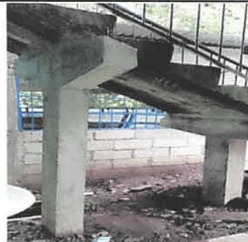
Foto 4: Reparación de gradas, reforzada con columnas.
